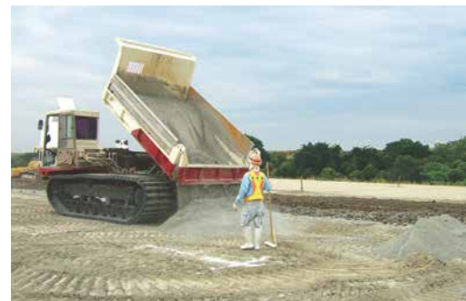
不整地運搬車使用
