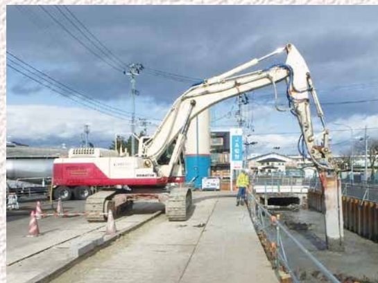
高低差のある現場
