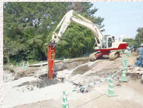
重機足場に傾斜がある現場
