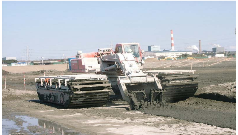
写真 - 1 施工状況
