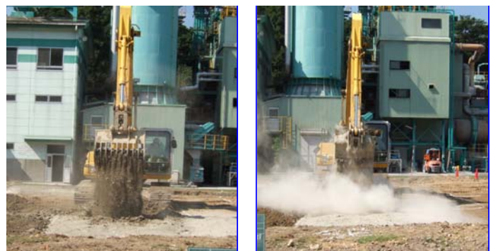
写真-2 湿潤セメント
