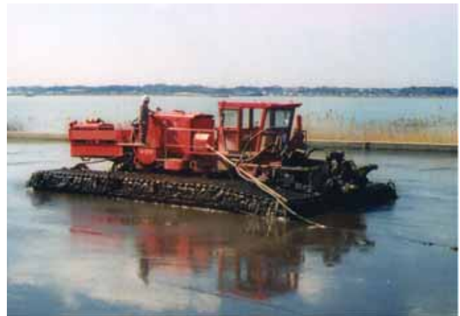
写真-1 施工状況 (ローター型)
